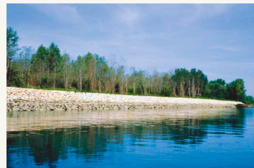
Verbautes Ufer an der Drau
